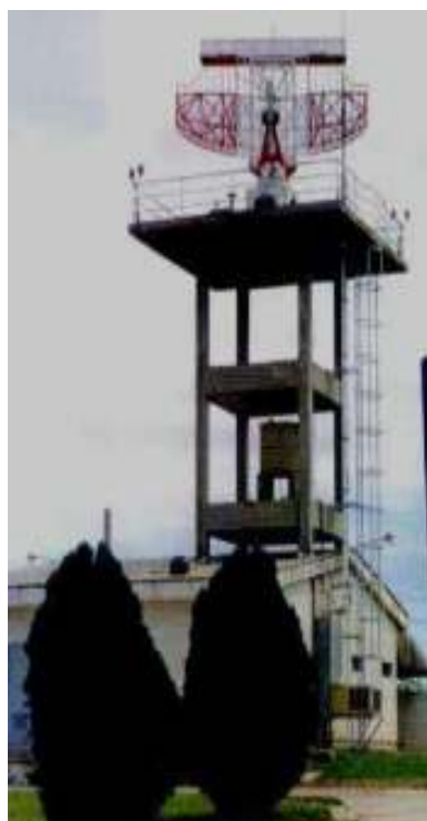
FIGURA X -3 – Sitio radar Córdoba
