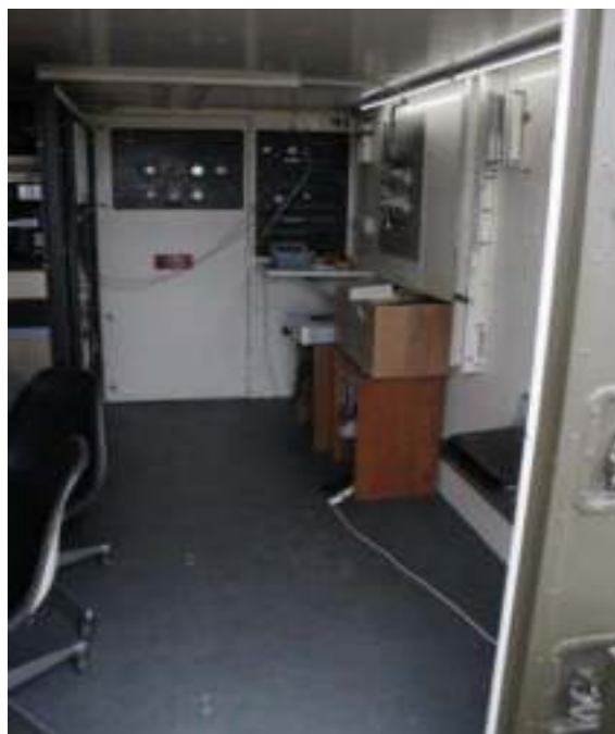
FIGURA VIII-43 – Otra vista de los trabajos en el interior del shelter.
