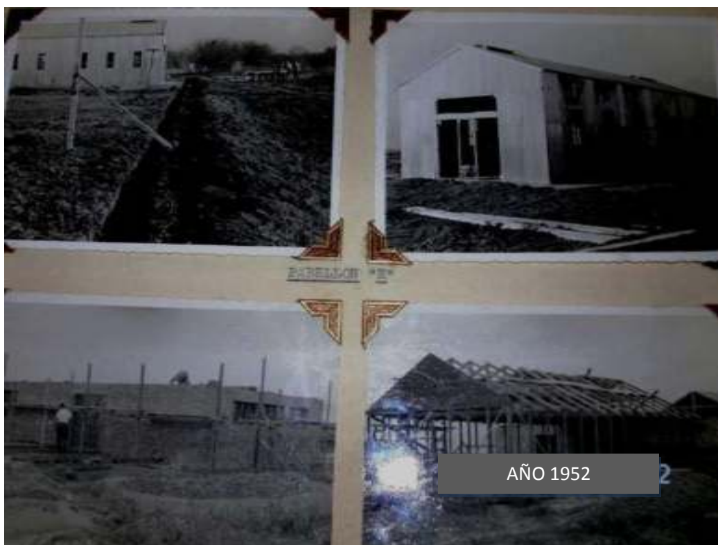
FIGURA II – 2 – Obras en el CIVA en Merlo Provincia de Buenos Aires
