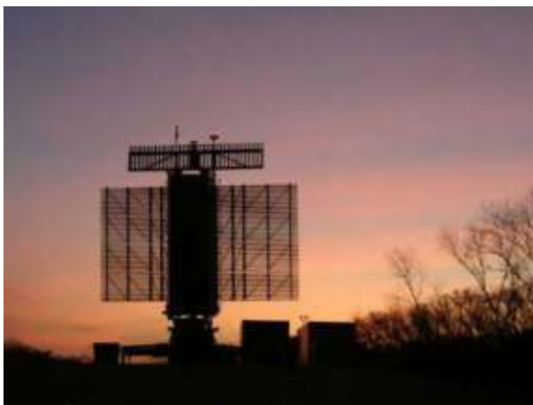
FIGURA X – 35 – Radar Lanza instalado en el sitio radar Morón
