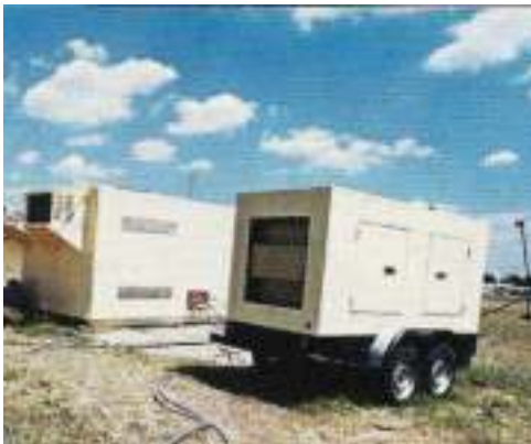
FIGURA X – 10 – Shelter con tableros y UPS y generador de energía eléctrica.
