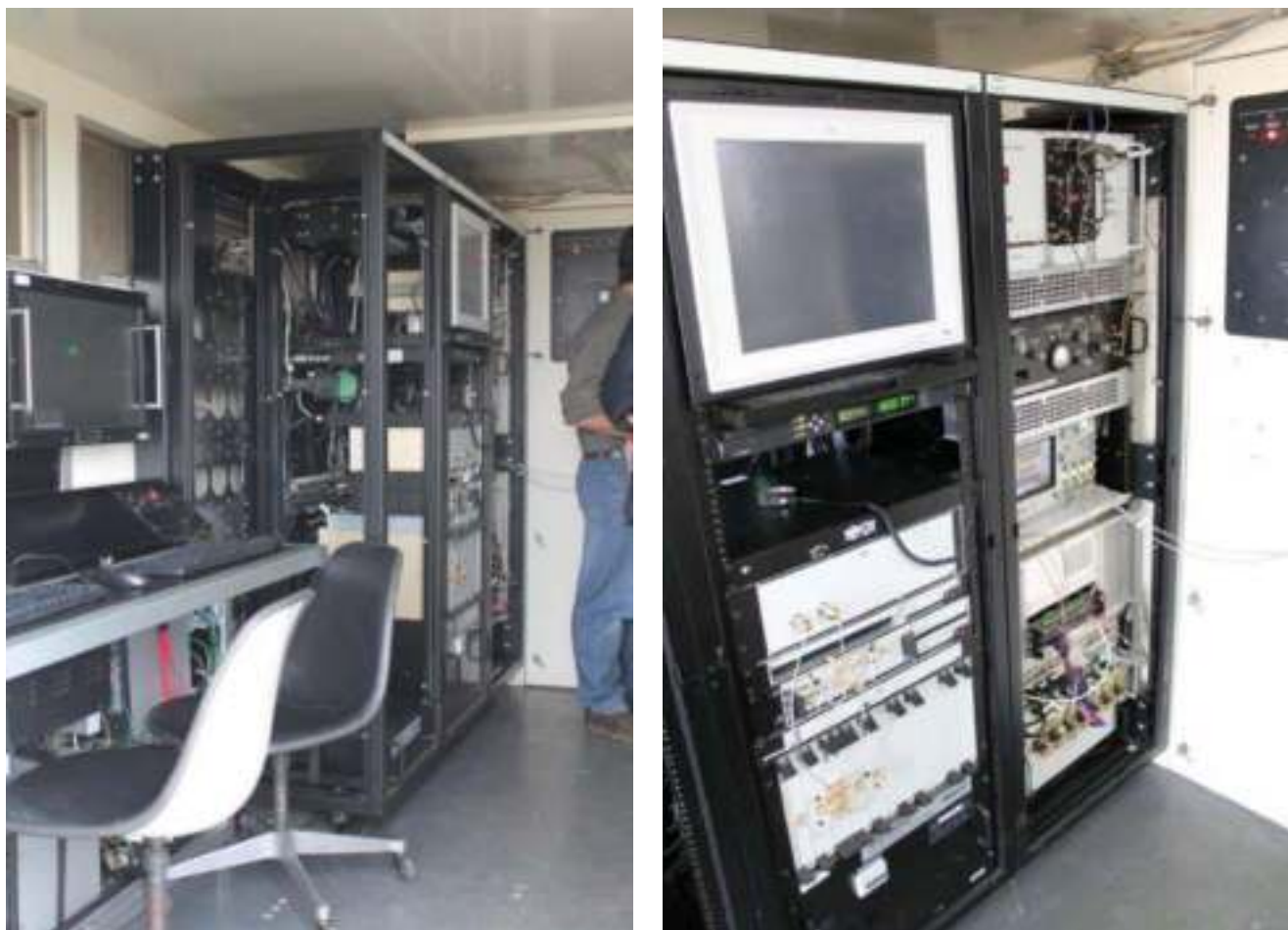
FIGURA VIII-42 - Distintas vistas de los trabajos en el interior del shelter.
