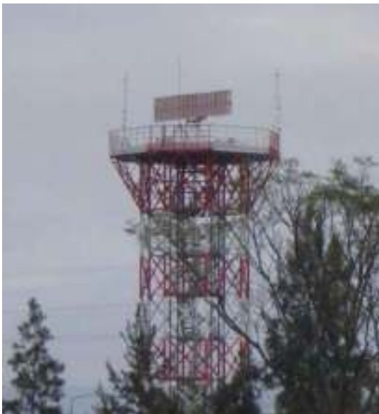
Sitio radar con torre estandarizada
