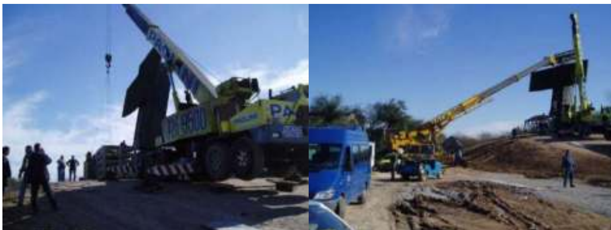
FIGURA X – 34 – Tareas de instalación del radar LANZA, una vez construida la plataforma de cuatro metros sobre el nivel del suelo.
