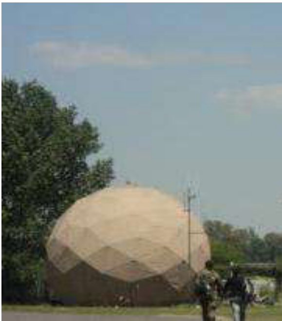
FIGURA VI - 8 – Armado del primer radome en el Grupo 2 VYCA.
