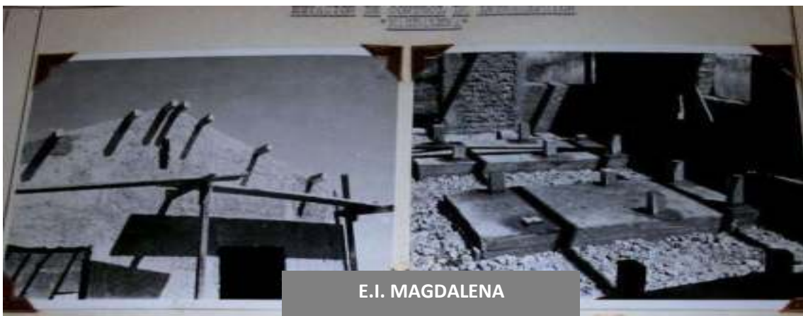
FIGURA II – 9 – Obras en la El Magdalena
