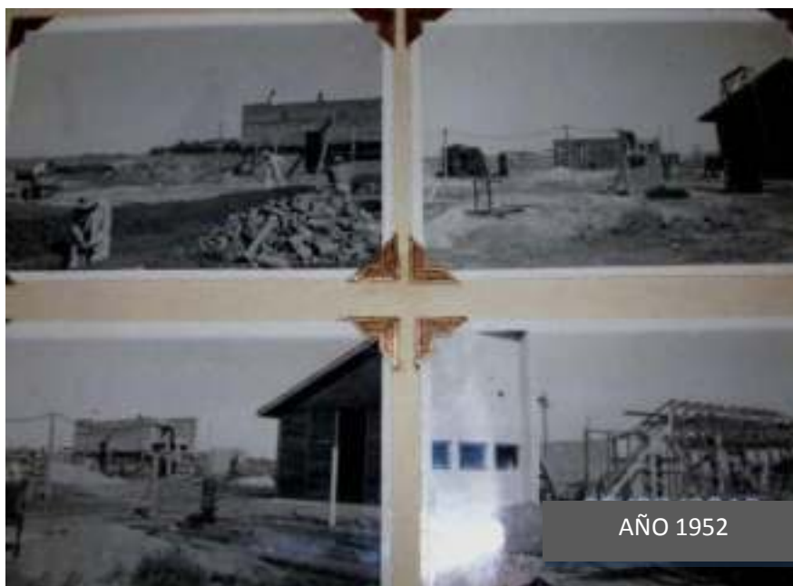
FIGURA II – 4 - Obras en el CIVA en Merlo Provincia de Buenos Aires
