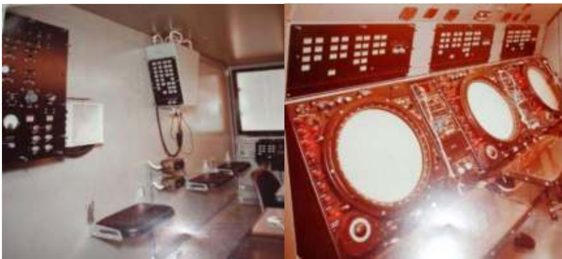
FIGURA IV - 26 – Cabina operativa de tres posiciones de control
