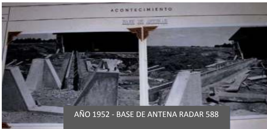
FIGURA II – 3 - Obras en el CIVA, en Merlo Provincia de Buenos Aires
