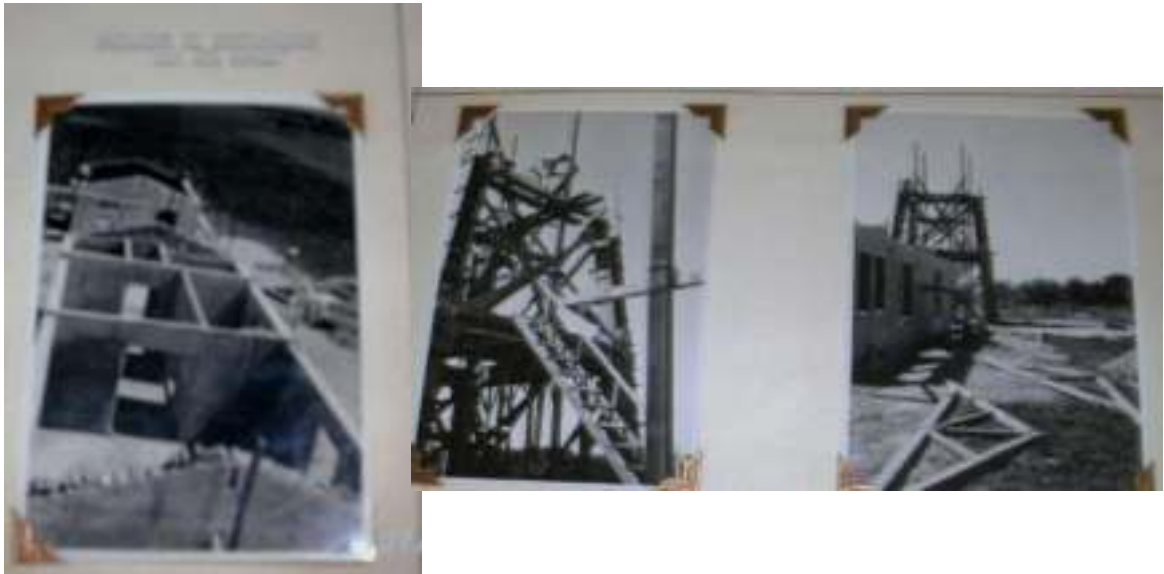
FIGURA II – 8 – Obras en la El Mar del Plata
