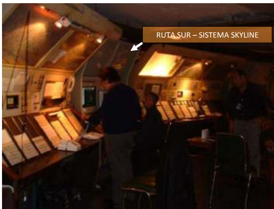
FIGURA X – 16 –Sala del ACC/TMA EZEIZA con el sistema “Skyline” instalado.
