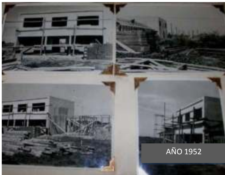
FIGURA II – 5 - Obras del CIVA en Merlo Provincia de Buenos Aires
