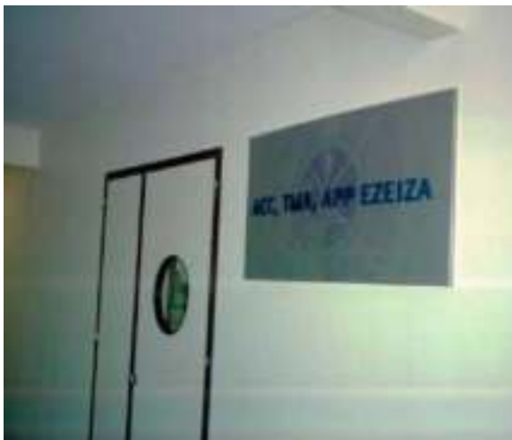
Ingreso a la nueva sala de control
