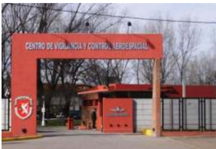
FIGURA VIII – 32 – Nuevo ingreso al Centro de Vigilancia y Control Aeroespacial
