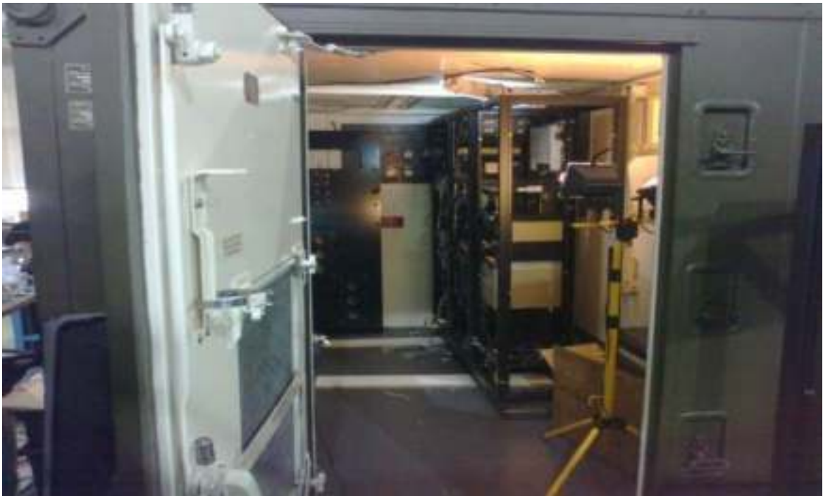
FIGURA VIII-41 - Distintas vistas de los trabajos en el interior del shelter.
