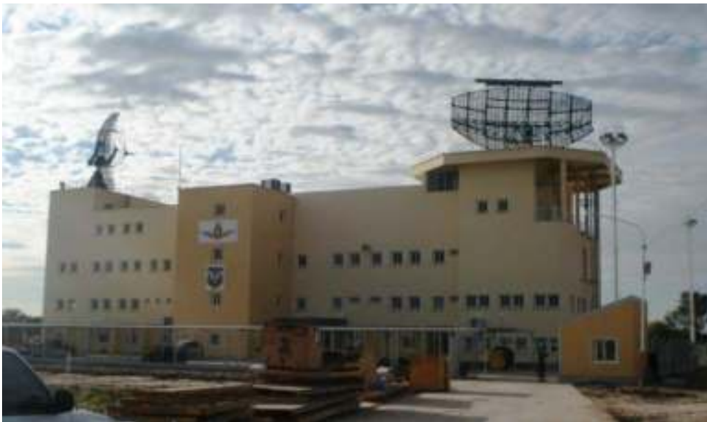
FIGURA VIII – 28 – Centro de Vigilancia Aérea Resistencia con el radar FPS 113/90 instalado
